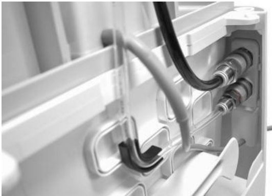
Fig. 6.3.4.12 : Raccordement du câble électrique, AWZ & dispositif de rinçage
