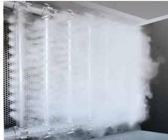
mogenen Dampfaustritt über die gesamte Querschnittsfläche. Über dem Strömungsquerschnitt auftretenden Feuchteschichtungen wird somit wirksam begegnet. Der eingebrachte Dampf wird rasch und gleichmäßig vom Luftstrom aufgenommen.
