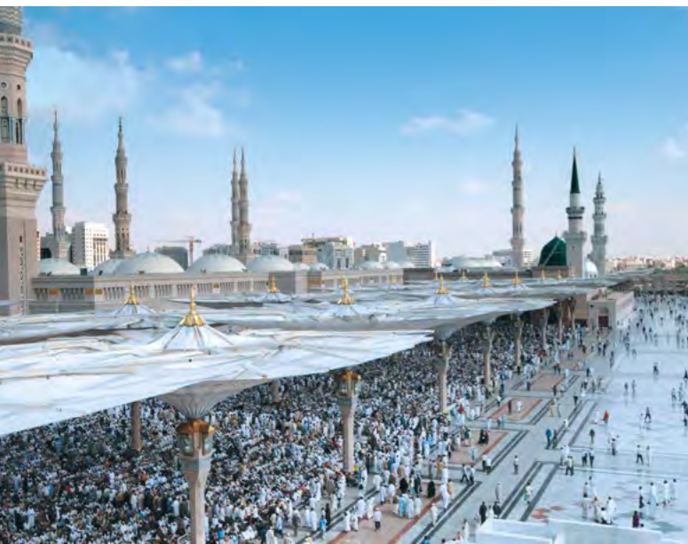
Refroidissement de l'air extérieur à Médine, Arabie saoudite
