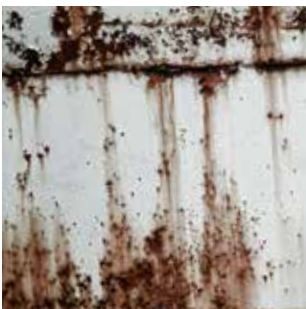
Schutz vor Rost und Korrosion
