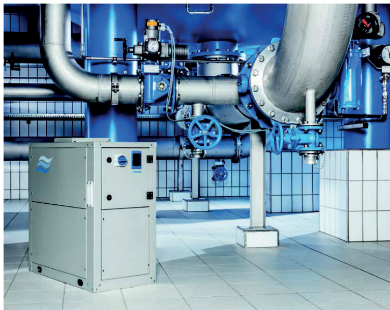
Entfeuchten in der Wasserversorgung
