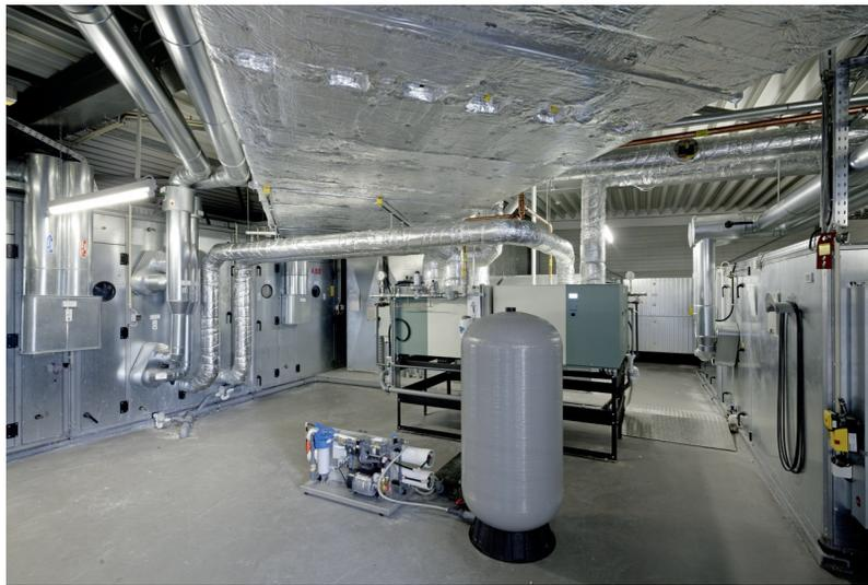
Abbildung 3: Die Dampfbefeuchtungsanlage „Condair GS“ (Vordergrund) und der Zuluftteil der RLT-Anlage im Campus Kronberg im Hintergrund links.
