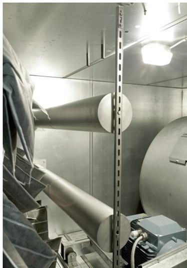
Abbildung 5: Die Zumischung der Abgase aus der Dampfbefeuchtung zur Abluft erfolgt über horizontale Verteilerrohre. (Alle Abb. Condair)
