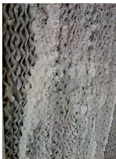
Abbildung 2: Im Laufe der Jahre haben sich auf den Befeuchterwaben starke Ablagerungen gebildet. Diese beeinträchtigen die Luftbefeuchtung und die Zuluft und verursachen durch hohe Druckverluste einen Mehrverbrauch an Ventilatorleistung zur Luftförderung.
