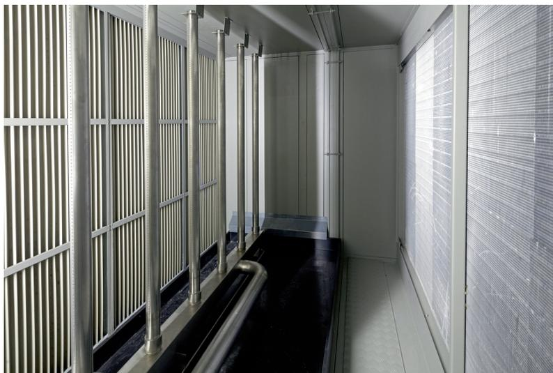
Abbildung 4: Auf der Zuluftseite strömt der Dampf über perforierte Lanzen (senkrechte Röhre links) ins RLT-Gerät.
