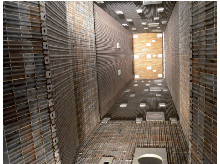
Blick nach oben im neuen, 35 m hohen Kessel der Müllverbrennung Spittelau in Wien.
