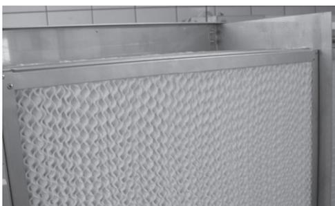
3. A partir du haut, déposer les éliminateurs de gouttes (pousser les éliminateurs vers le haut et les déposer vers l'avant).
