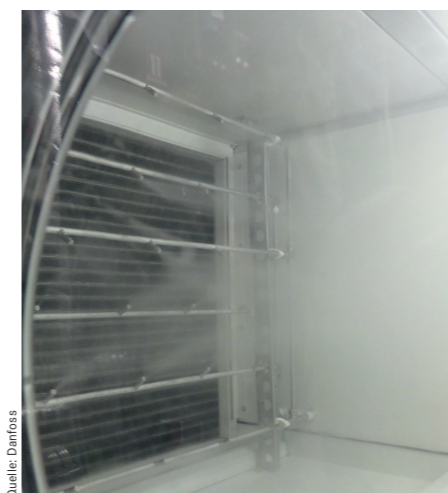
Adiabates Befeuchtungssystem im Operationssaal für Knochenmarktransplantationen im Klinikum Marburg: Zuluftbefeuchtung und adiabate Abluftkühlung
