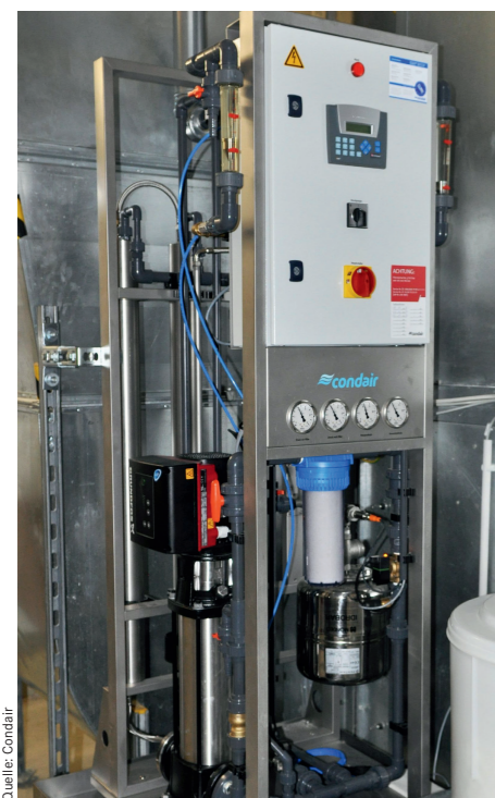
Umkehrosmoseanlage im Bundesratsgebäude
