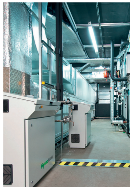
In der Blutzentrale des Österreichischen Roten Kreuzes in Linz wurden die bestehenden Dampfbefeuchtungssysteme in den RLT-Zentralen auf eine Lösung mit Hochdruckdüsen umgestellt: Technikraum mit RLT-Zentralgräten und zwei Hochdruckbefeuchtungsanlagen
