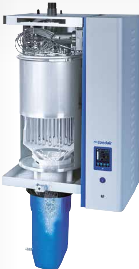
Kalk wird aus dem Gerät und in den Auffangbehälter abgeführt
